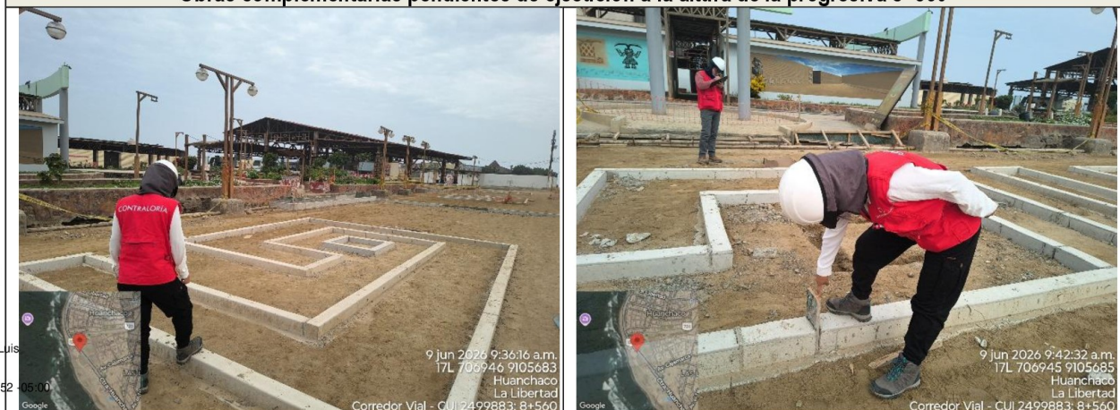
Obras complementarias pendientes de ejecución a la altura de la progresiva 8+560
